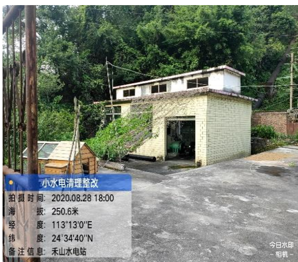
(a) 发电厂房外貌全景
