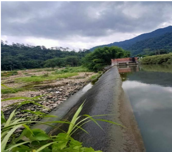
(c) 大坝及库区
