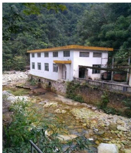
(b) 厂房外景全貌
