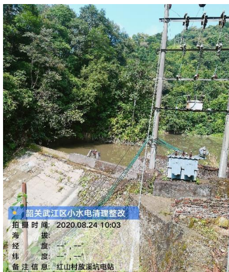
(c) 大坝及库区
