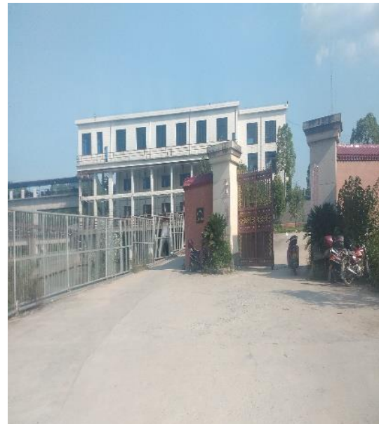
(d) 厂房外景全貌
