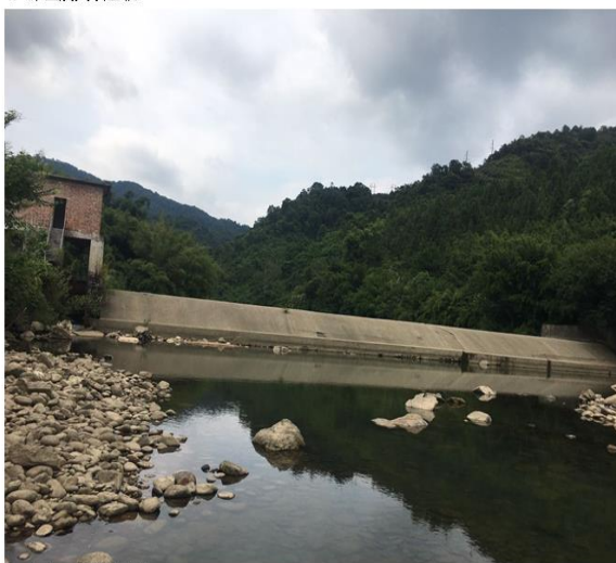
(e) 大坝及库区
