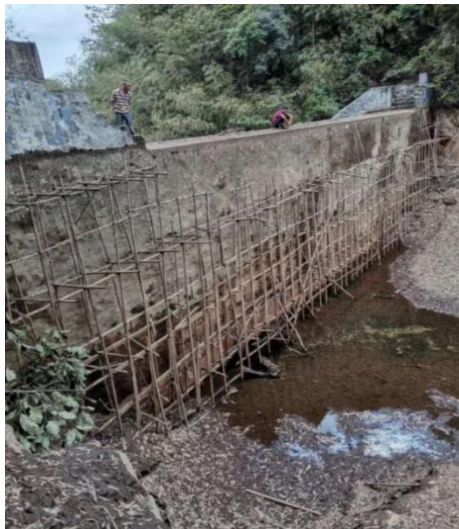
(c) 大坝及库区
