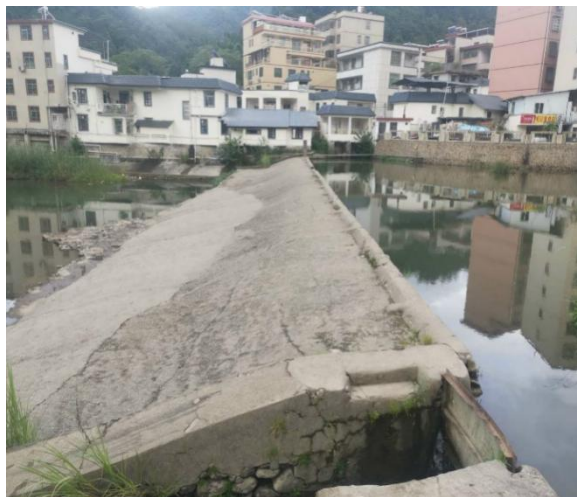
(c) 大坝及库区
