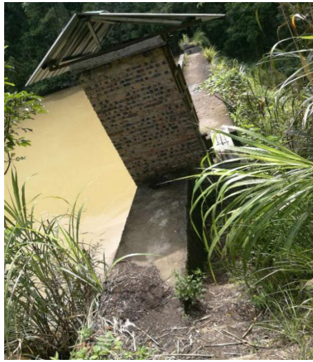
(c) 大坝及库区
