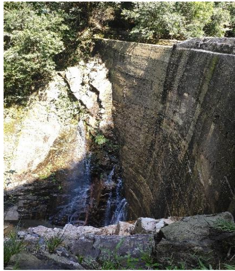
(d) 库区及大坝全貌
