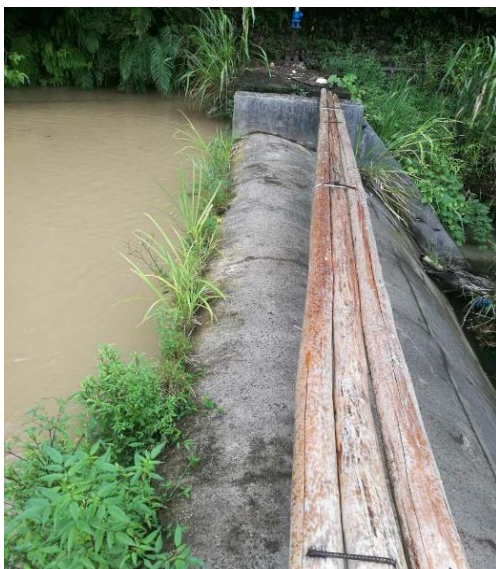
(c) 大坝及库区
