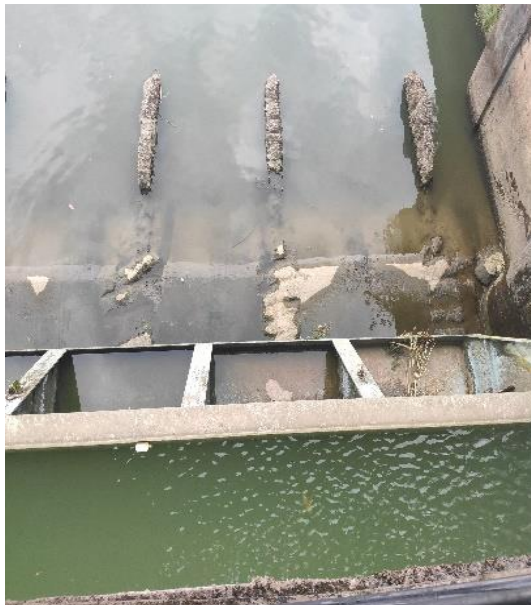
(c) 大坝及库区
