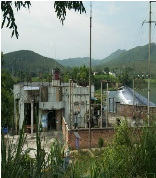
(a) 厂房外景全貌
