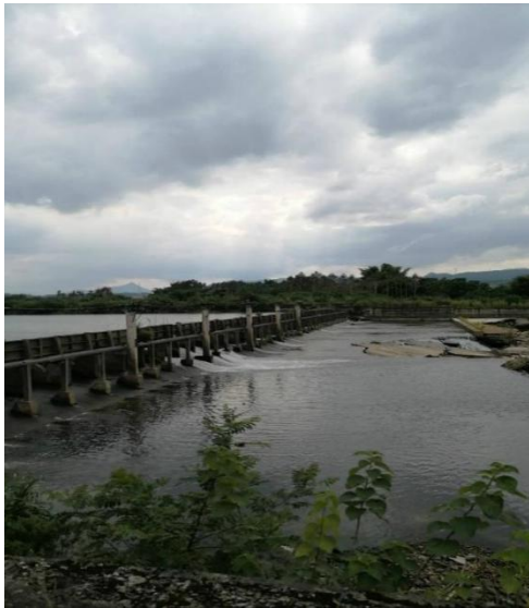
(c) 大坝及库区
