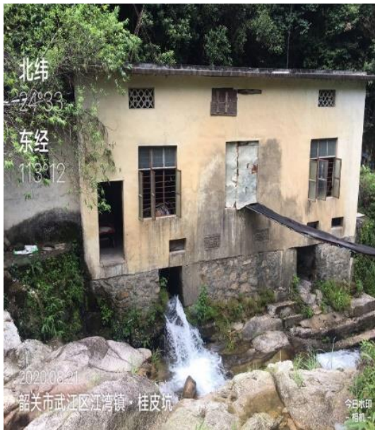
(a) 厂房外景全貌
